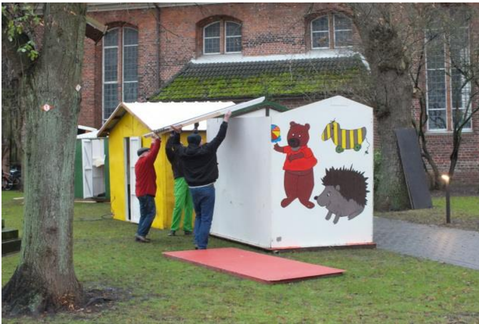
Noch nicht ganz dicht: Dacharbeiten sind bei Sturm und Regen eine Herausforderung
