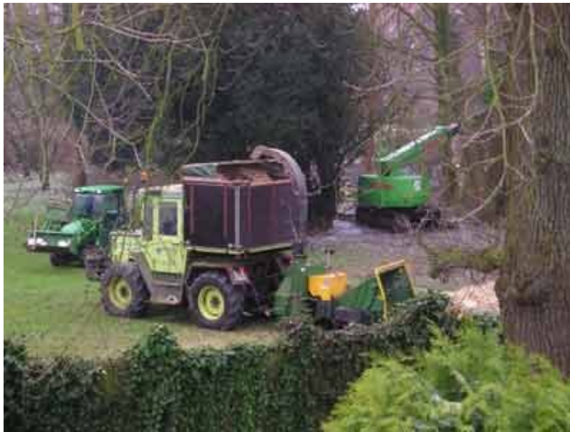
Sanierung des Fleetes am Pastorat
