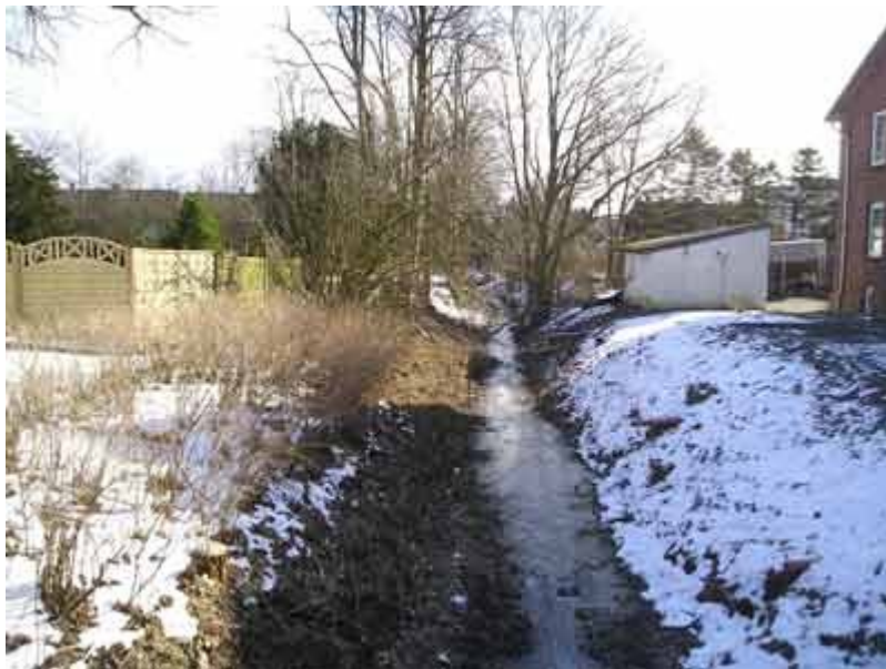
Fleet am Pastorat nach der Sanierung
